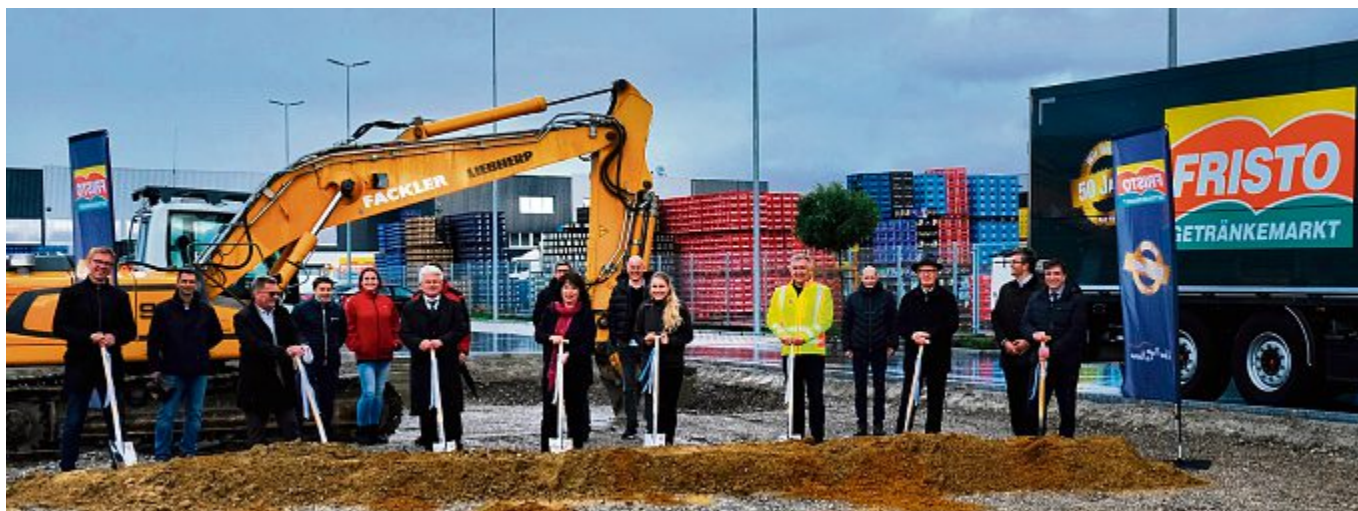
Spatenstich für den Neubau der rund 2775 Quadratmeter großen FRISTO Firmenzentrale Anfang Oktober in Buchloe.
